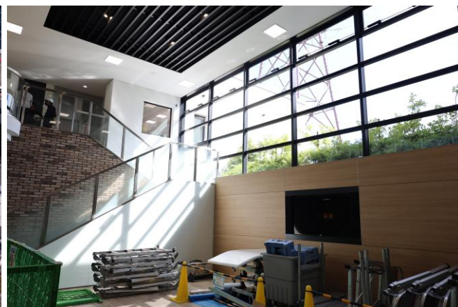
エントランスホール(工事準備中)
