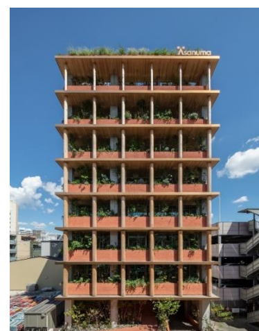
ファサード全景
