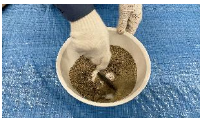
写真4 材料混合状況
