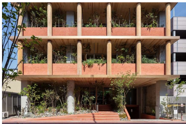
建設残土を用いた土壁や吉野杉などの自然素材を用いたエントランス
