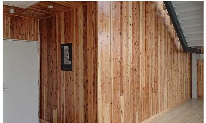
CLT（直交集成板）を用いた内壁
