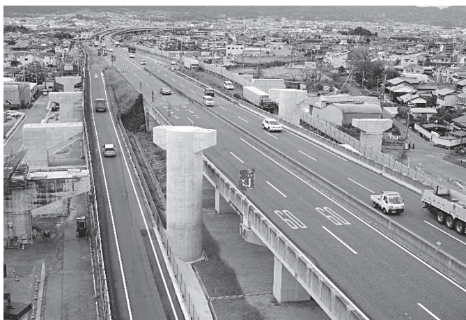
大和御所道路橿原高田 I Cランプ橋(C P 6 他)下部工事
