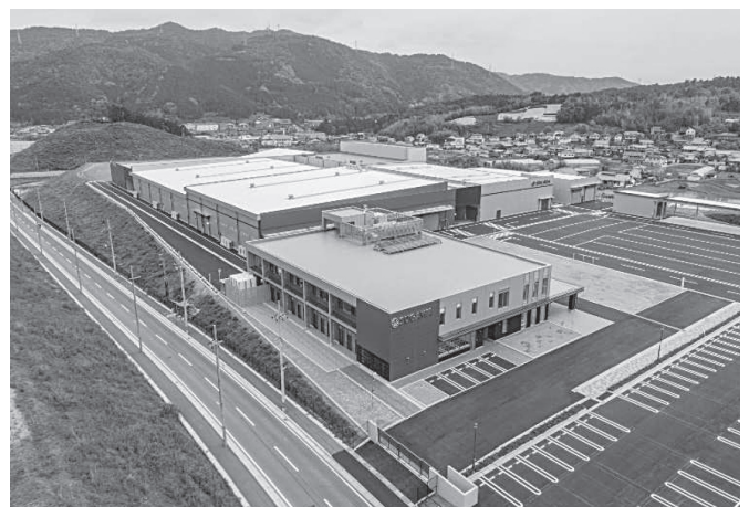
須河車体株式会社 新工場新築工事(建築工事)
