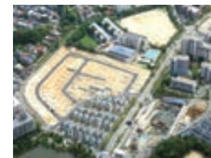
枚方市香里ヶ丘(C-3)(C-4b)(C-7)宅地造成工事
