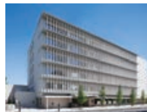
世田谷地方合同庁舎(仮称)(13)建築その他工事
