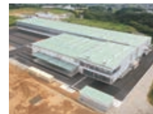
ホクト株式会社(仮称)富山きのこセンター新築工事
