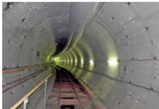
二葉の里地区下水道築造23-13号工事
