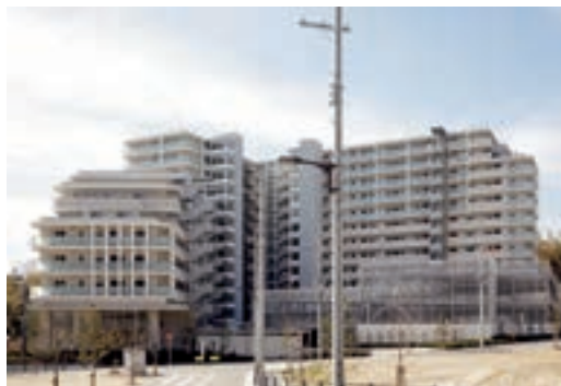
ロジマン千里中央新築工事
