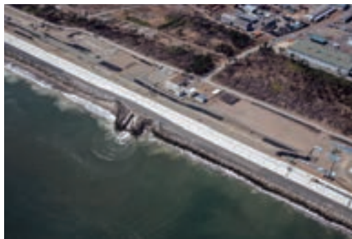
仙台湾南部海岸二の倉工区南部第8復旧工事
