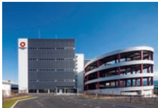
(仮称)Dプロジェクト 相模原物流センター新築工事
