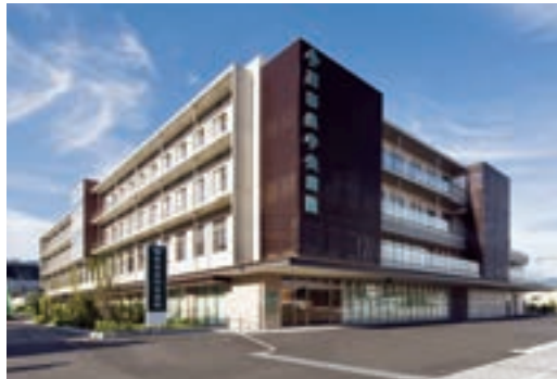
西奈良中央病院新築工事
