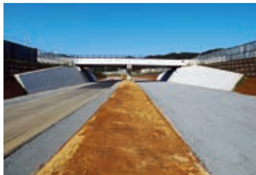
さがみ縦貫都畑・中沢地区改良工事
