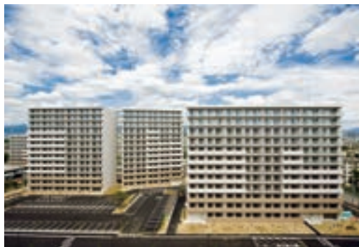
公務員宿舍枚方住宅(I期)整備事業に係る建設工事(PFI)
