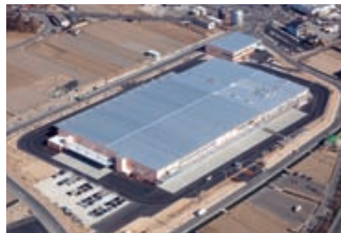
(仮称)ハローズ早島物流センター新築工事
