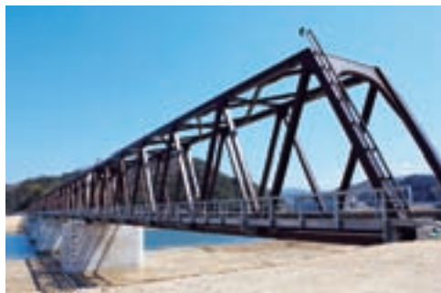
宮津線円山川橋りょう架替その2工事(下部工他・終点方)
