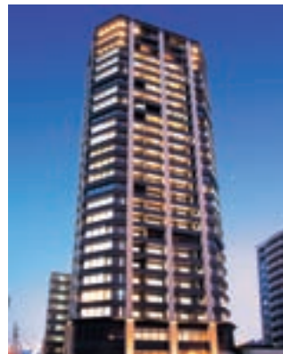
タワー・ザ・ファースト静岡新築工事
