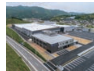
須河車体株式会社新工場新築工事(建築工事)
