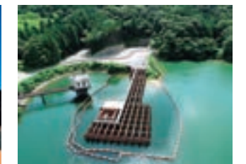
豊川用水二期西部幹線併設水路駒場地取水工工事
