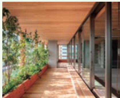
既存の外壁面をセットバックし ベランダ空間を創出
