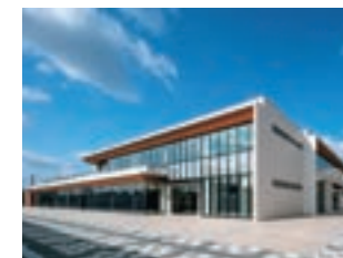
摂南大学寝屋川キャンパス3・4号館新築等工事
