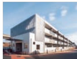
(仮称)南青山アパート災害公営住宅建設工事
