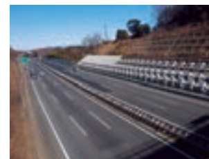
関越自動車道 嵐山工事
