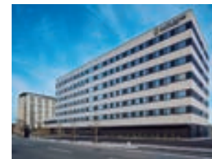
広野駅東側ホテル整備事業プロジェクト工事
