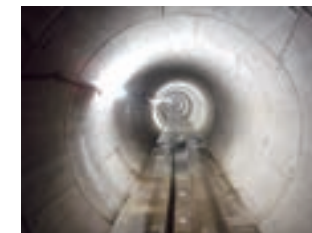
杉並区荻窪二、四丁目付近 枝線工事
