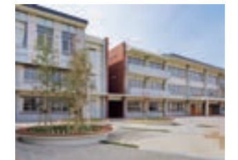
泉南中学校改築工事
