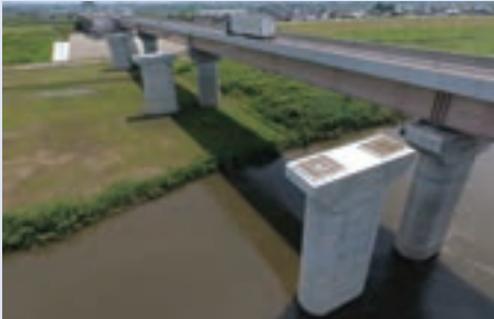
R2圏央道鬼怒川橋下部工事
