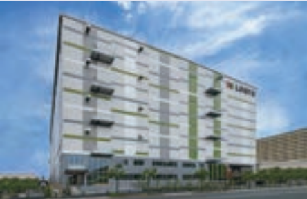
LOGI'Q南砂町新築工事
