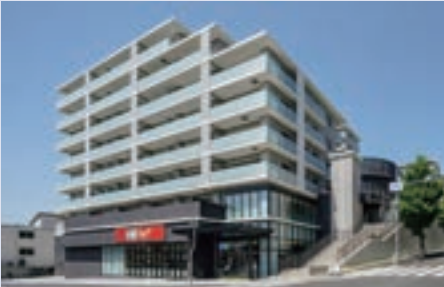
北鈴蘭台駅前地区第一種市街地再開発事業施設建築物新築工事
