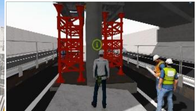
高速跨道橋橋脚補修
