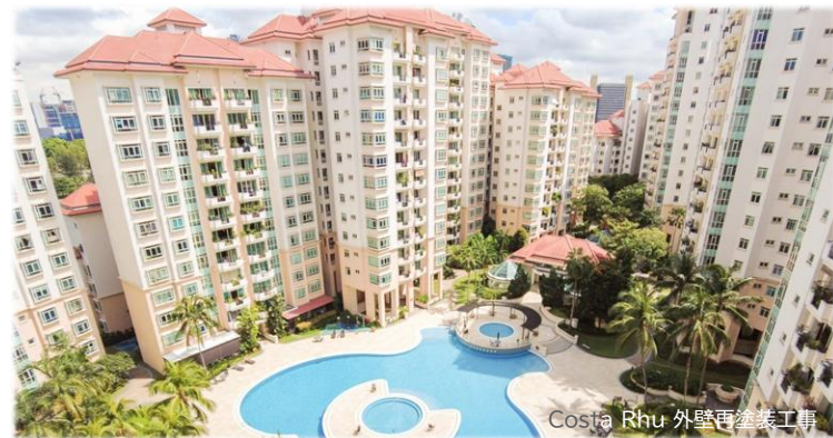
Costa Rhu 外壁再塗装工事
