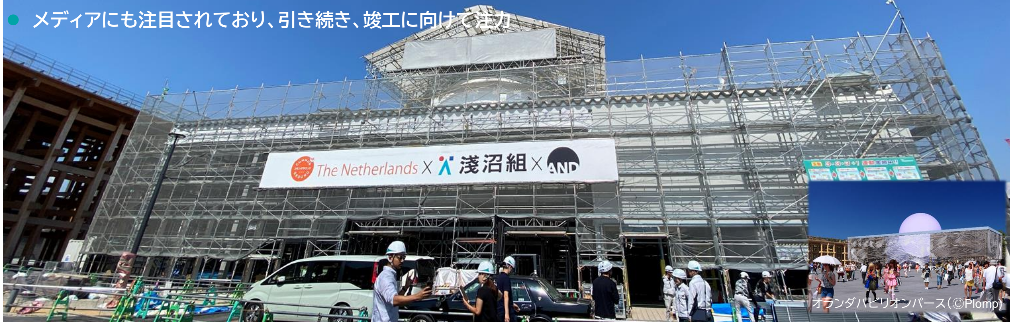
施工状況(2024年10月1日撮影)
