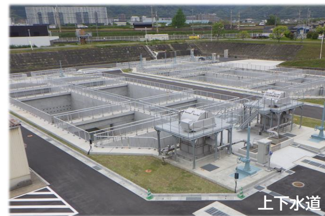
楠葉取水施設耐震改良(大阪府)2023
