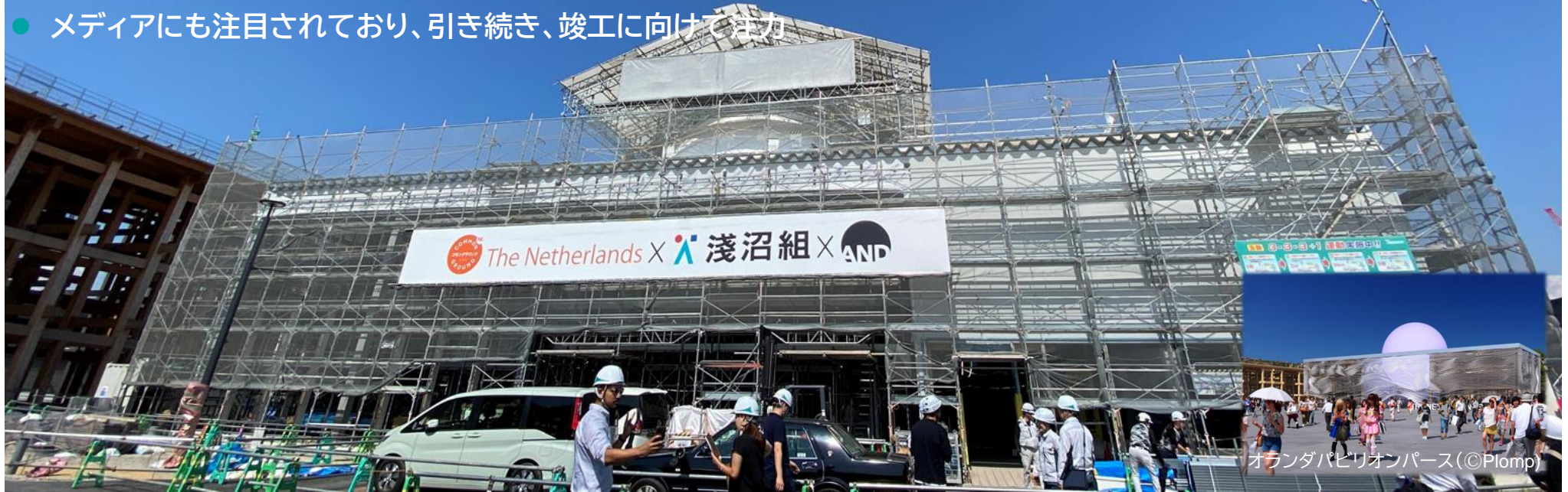
施工状況(2024年10月1日撮影)
