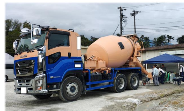
実証実験状況
