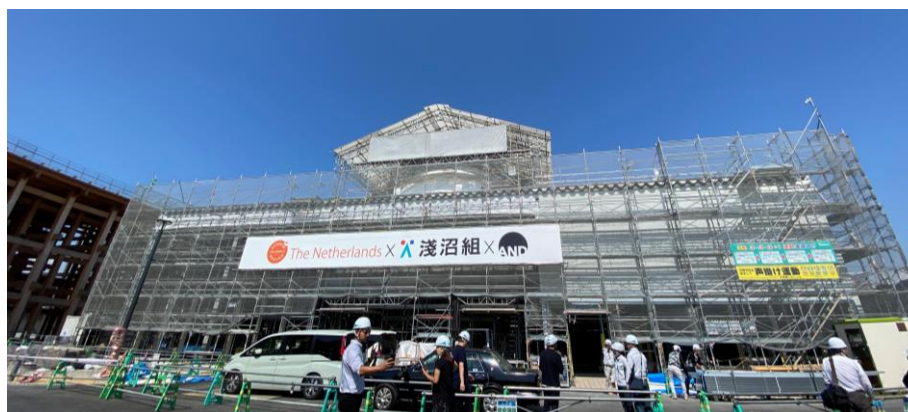
施工状況(2024年10月1日撮影)
