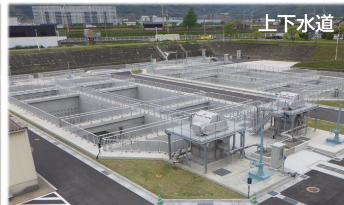
楠葉取水施設耐震改良(大阪府)2023
