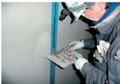
PRS目地充填工法施工状況
