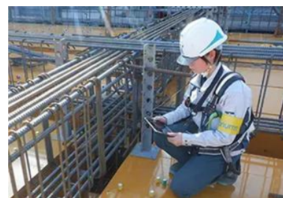
タブレットで配筋を検査
