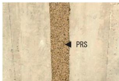
PRS目地充填状況
