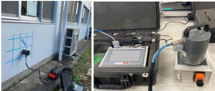
西多賀幼稚園様(宮城県仙台市)のRC調査診断作業の様子
