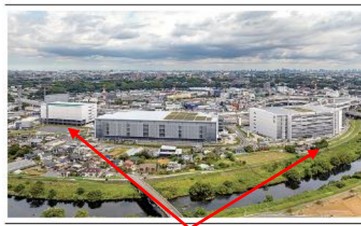
全3棟のうち当社が2棟施工
