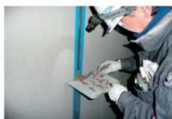
PRS目地充填工法施工状況
