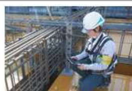
タブレットで仕上がり検査
