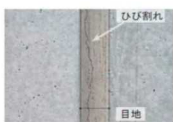
CCB工法によりひび割れ誘発
