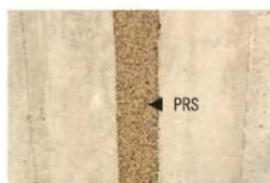
PRS目地充填状況
