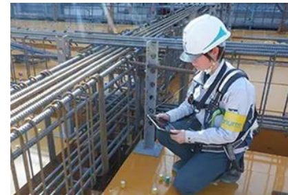
タブレットで仕上がりを検査
