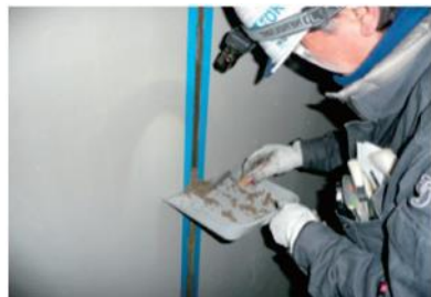
PRS目地充填工法施工状況
