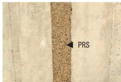
PRS目地充填状況
