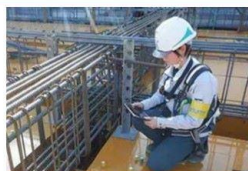
タブレットを利用した配筋検査
