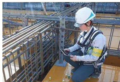
タブレットを利用した配筋検査
