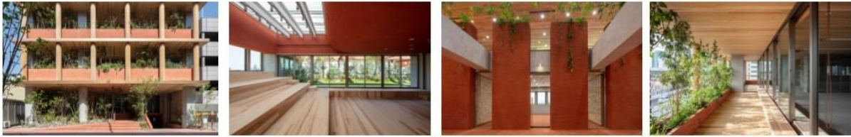
近郊作業所からの残土を利用した珪土ブロック
