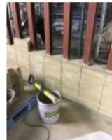
近郊作業所からの残土を利用した珪土ブロック
