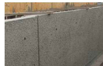
環境配慮型コンクリート
