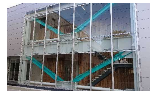
2 増築棟 制震ダンパー
