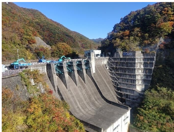
図-9 ダム点検システムの試行現場
