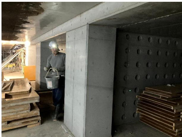
図-13 狭隘な施工部位における充填状況の確認
