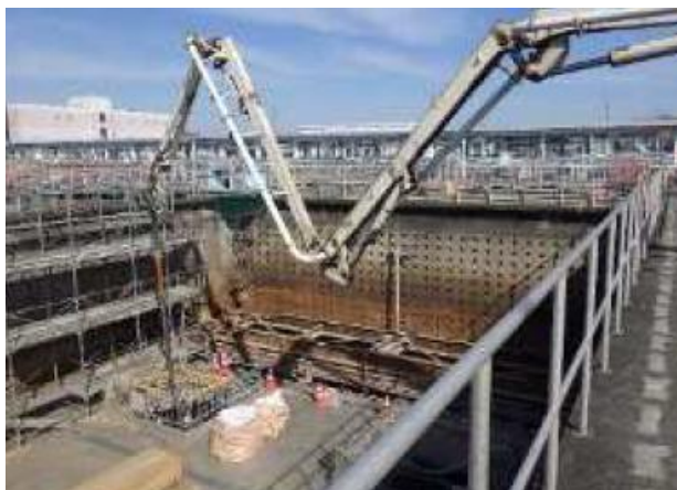
図-12 朝霞浄水場耐震補強工事における SFC 適用
