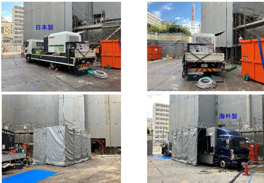
写真-1 超高圧ポンプ+エンジンコンプレッサの配置および防音シートの設置状況
