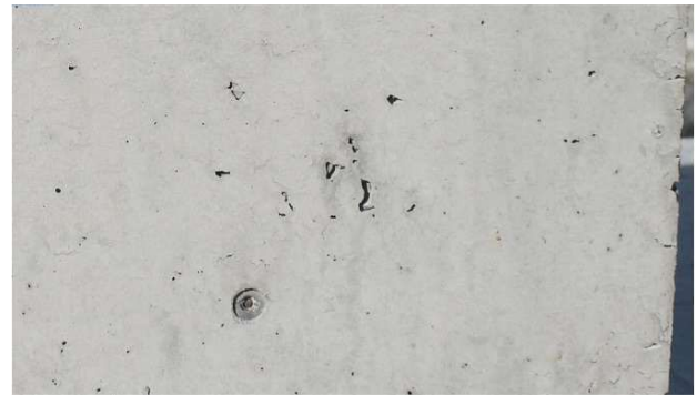
写真-2 表層変状 (表面気泡の例)
