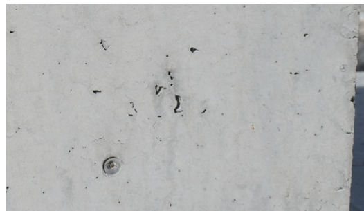
写真-2 変状の例(気泡)
