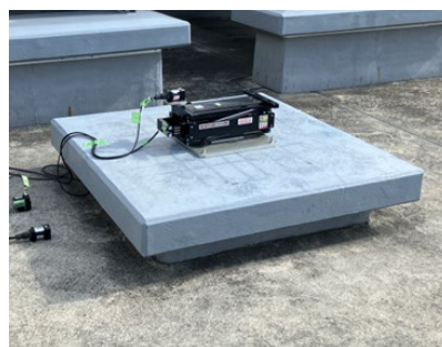
写真-5 加振機の設置状況
