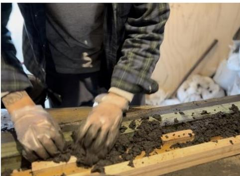
写真-6 壁板作製時の様子
