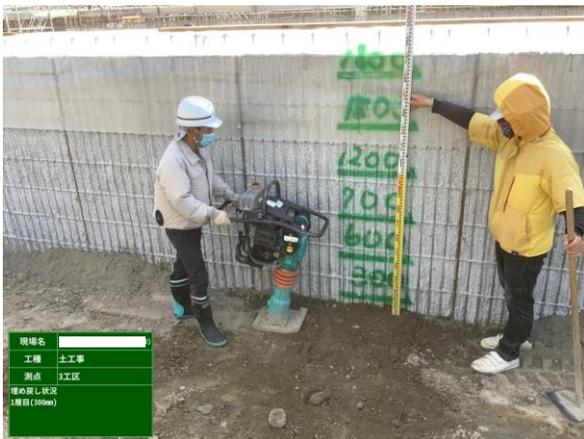
写真-2 埋戻し土の施工状況
