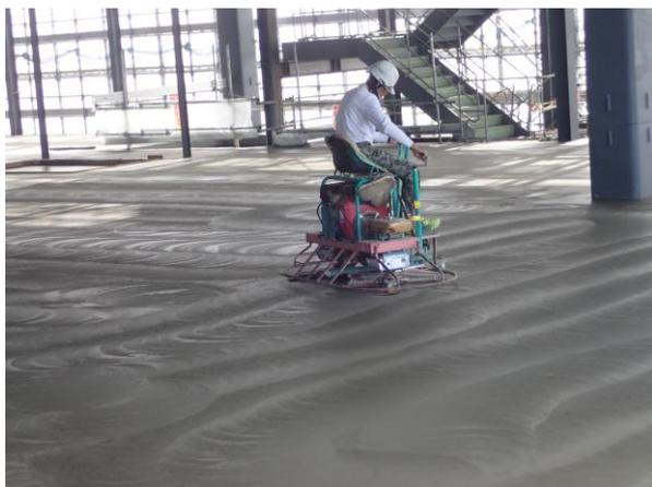
写真-5 コンクリート押さえ状況
