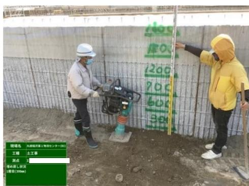
写真-2 埋戻し土の施工状況
