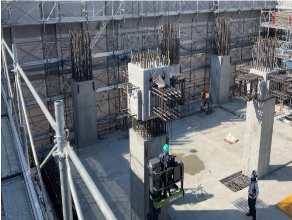
図-7-1 仕口 PCa 設置状況
