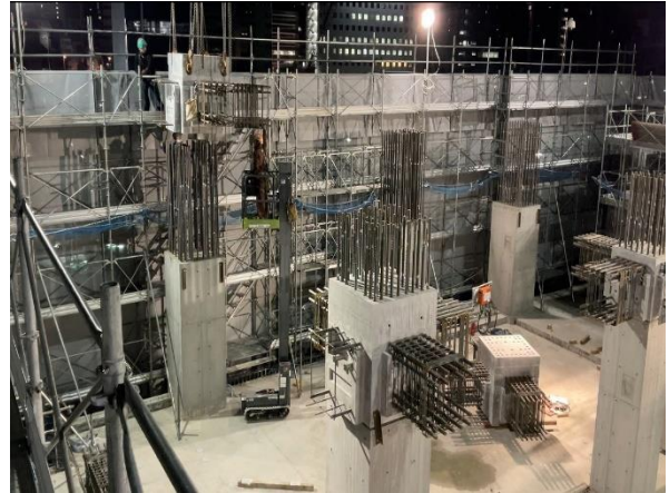
図-7-2 仕口 PCa 設置状況(夜間施工)
