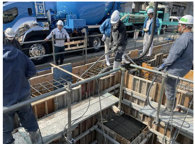
写真-4 基礎地中梁打込み状況
