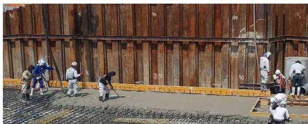
写真-2 BB+FA コンの圧送による打込み状況
