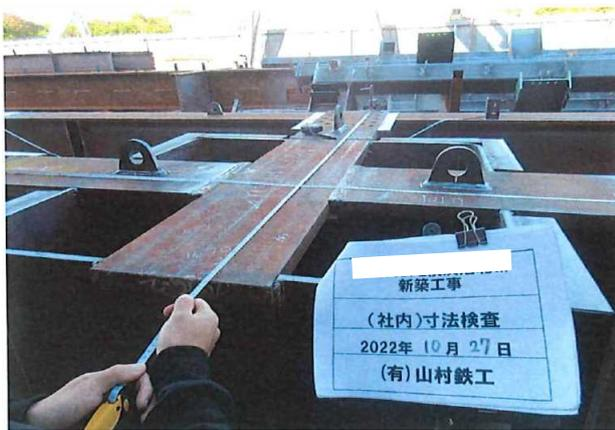
写真 5-2 仕口部寸法検査
