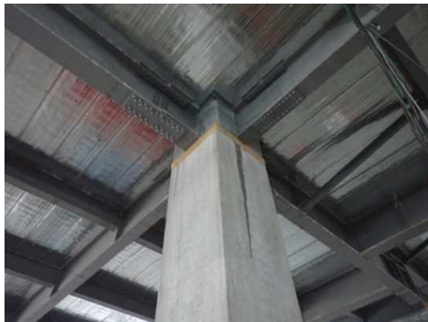
写真1 RCS造の柱と梁
