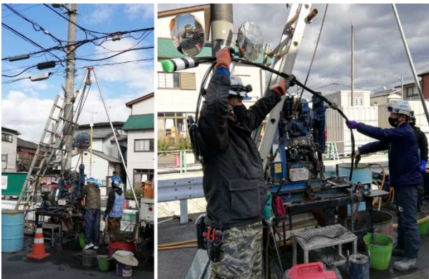
写真-7 変位センサ設置状況（道路上での施工）
