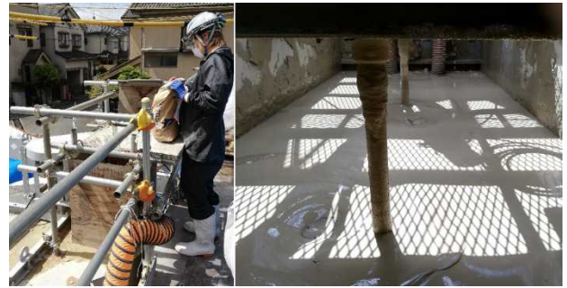
写真-3 作泥状況
