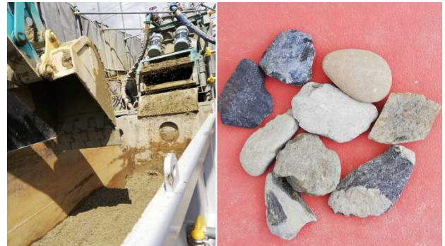
写真-4 排出残土と破碎された礫片
