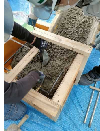
写真－3 コンクリート打込み状況
