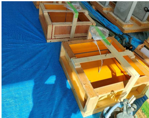
写真－1 型枠状況
