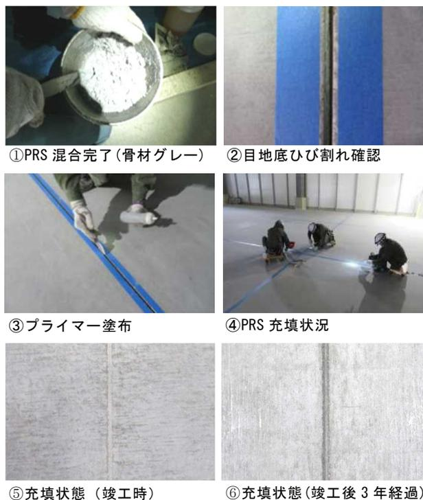
図-28 PRSの床目地施工状況
