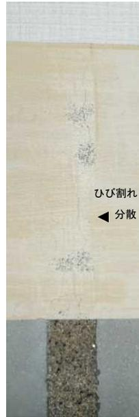
写真-13 実建物目地のひび割れ分散現象
