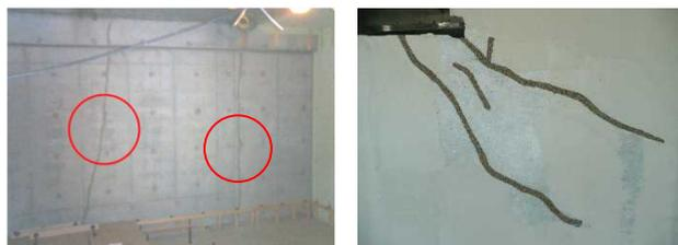
写真-14 ひび割れの補修事例
