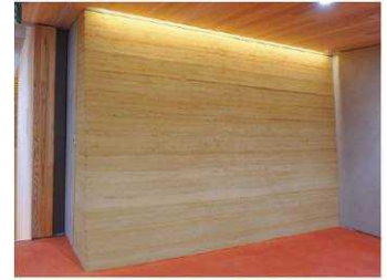
写真-10 版築壁完成写真
