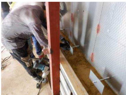
写真-8 版築壁施工状況
