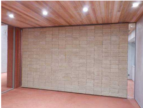
写真-4 イモ目地版築ブロック壁
