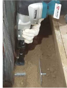
写真-9 締固め状況
