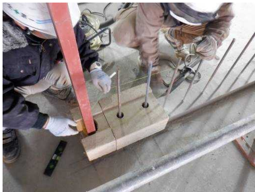
写真-2 版築ブロック壁施工状況（ウマ目地）
