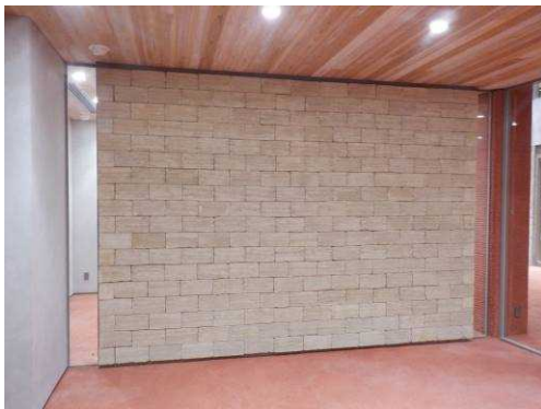
写真-5 ウマ目地版築ブロック壁
