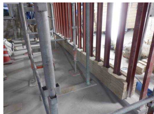
写真-3 版築ブロック壁 鉄骨下地（イモ目地）
