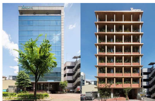
写真-1 外観比較（左：改修前/右：改修後）
