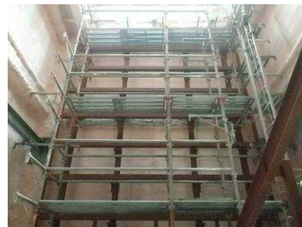
写真-13 左官壁下地鉄骨
