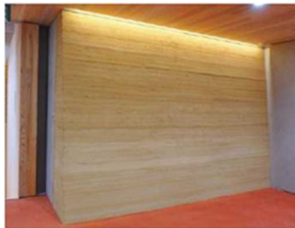
(中上) 写真-2 イモ目地版築ブロック壁
