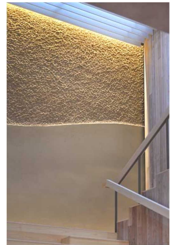
写真-4 左官壁完成写真
