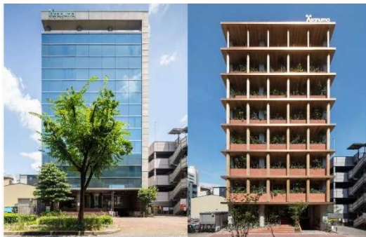
写真-1 外観比較 (左:改修前/右:改修後)
