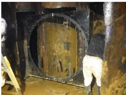
写真-5 鋼管矢板坑口設置状況
