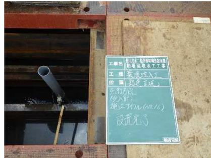
写真-2 塩ビ管 VU75 設置状況
